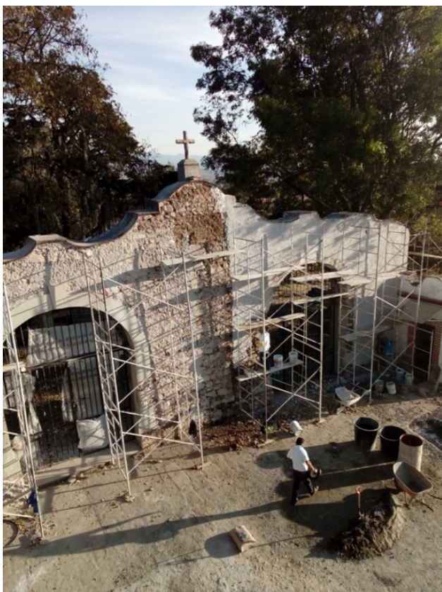
Imagen 10. Proceso de restauración del arco de entrada al Santuario (fuente: Cortesía de Eder Torres Villamar del Consejo Parroquial, 2018).
