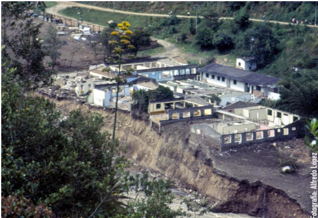
Foto 7. Daños causados por la avalancha. Municipio de Belalcázar. Foto: Alfredo López, 1994
