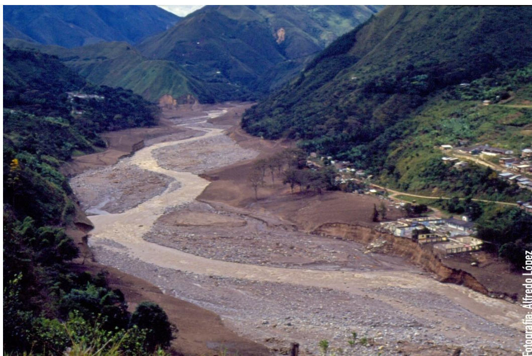
Foto 6. Daños causados por la avalancha- Municipio de Belalcázar. Foto: Alfredo López, 1994
