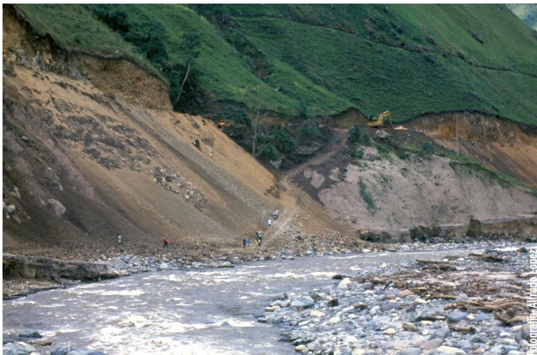
Foto 8. Destrucción de la carretera Belalcázar – Cuetandó. Foto: Alfredo López, 1994
